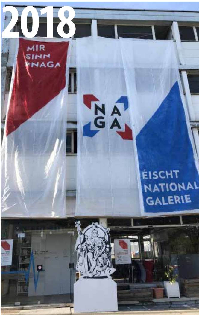
Facade vun der "NAGA" zu Bouneweg
